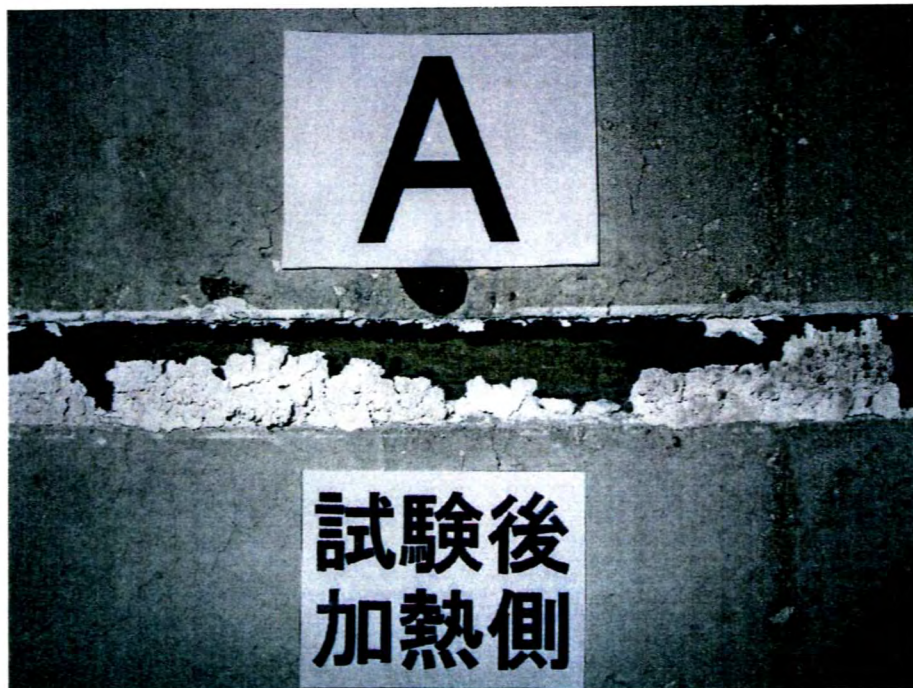
写真-14 試験後の水平スリット部（加熱側，屋外側）の状況 （試験体記号A）
