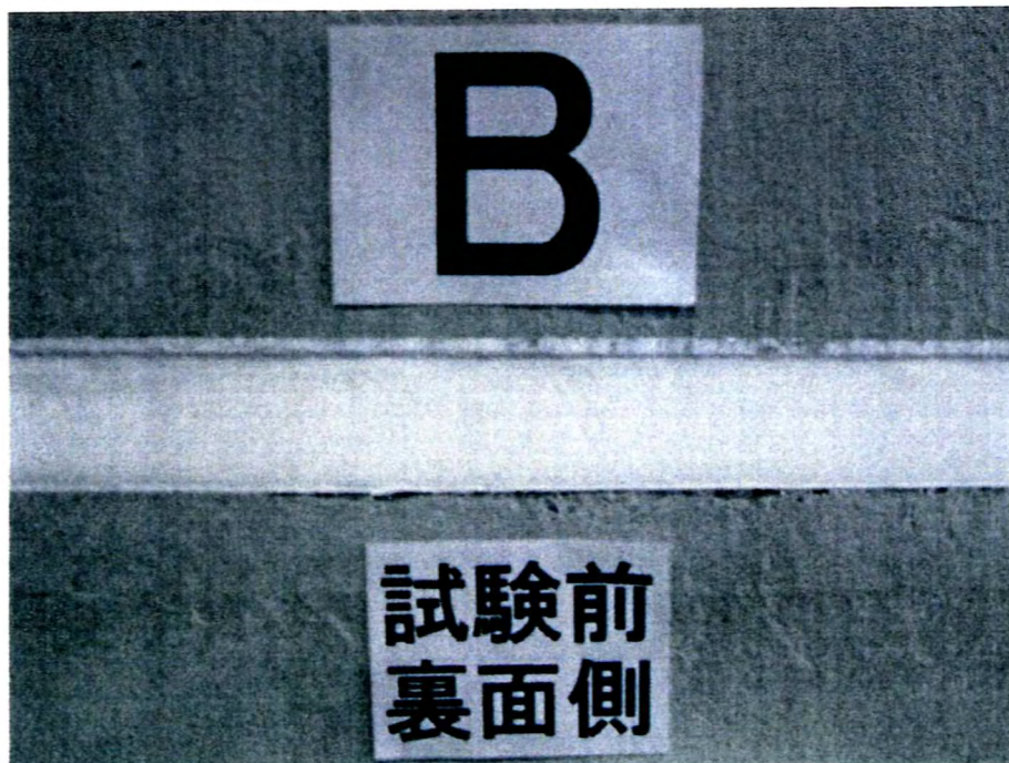
写真-10 試験前の水平スリット部（裏面側，屋外側）の状況 （試験体記号B）
