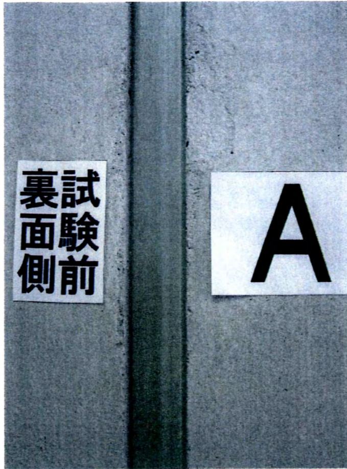
写真-5 試験前の鉛直スリット部（裏面側，屋内側）の状況 （試験体記号A）
