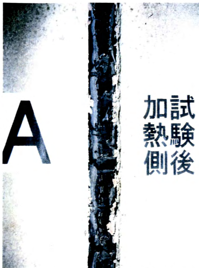
写真-13 試験後の鉛直スリット部（加熱側，屋外側）の状況 （試験体記号A）
