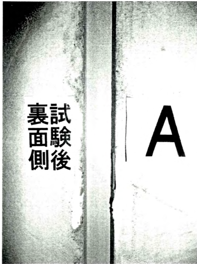
写真-15 試験後の鉛直スリット部（裏面側，屋内側）の状況 （試験体記号A）
