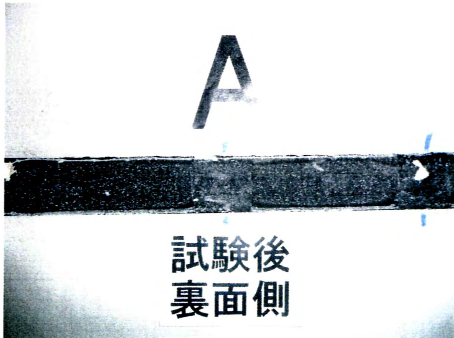
写真-16 試験後の水平スリット部（裏面側，屋内側）の状況 （試験体記号A）
