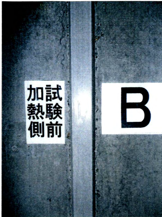
写真-7 試験前の鉛直スリット部（加熱側，屋内側）の状況 （試験体記号B）
