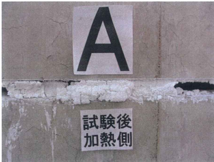
写真-14 試験前の水平スリット部（加熱側，屋外側）の状況 （試験体記号A）
