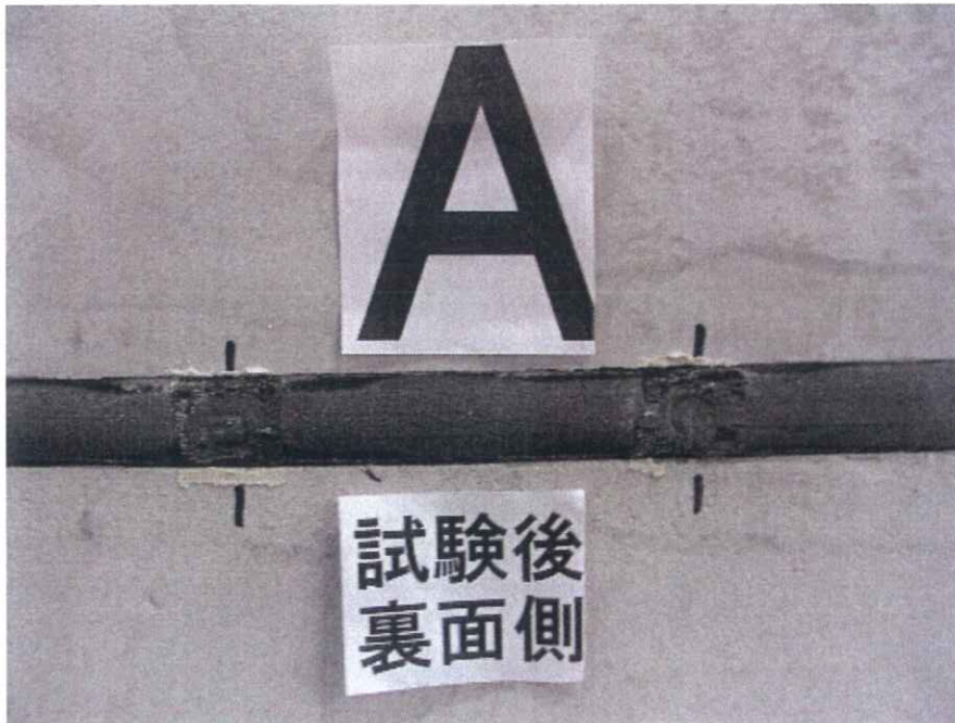
写真-16 試験後の水平スリット部（裏面側，屋内側）の状況 （試験体記号A）
