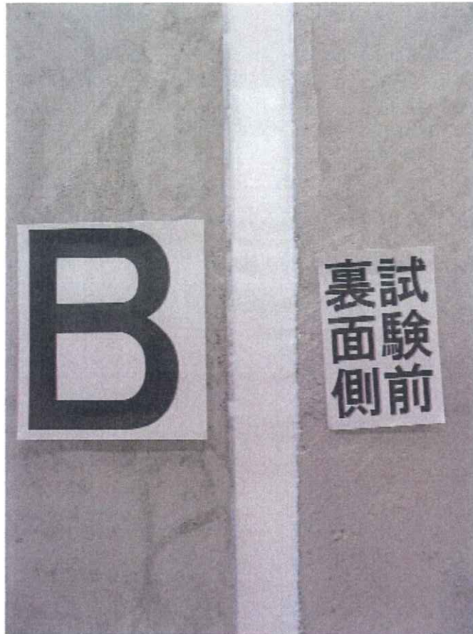
写真-9 試験前の鉛直スリット部（裏面側，屋外側）の状況 （試験体記号B）
