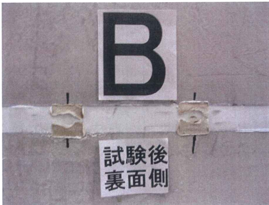
写真-20 試験後の水平スリット部（裏面側，屋外側）の状況 （試験体記号B）
