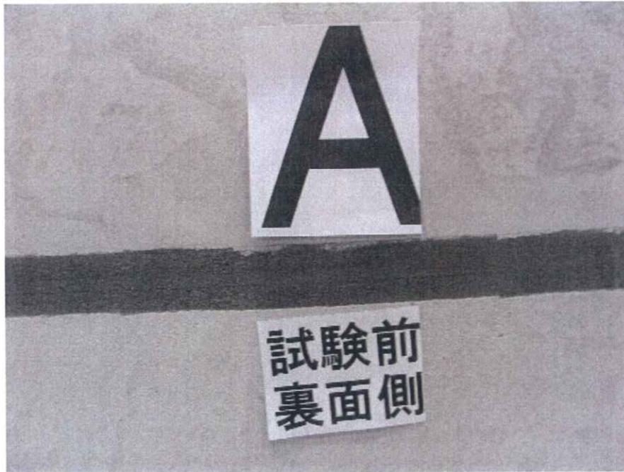
写真-6 試験前の水平スリット部（裏面側，屋内側）の状況 （試験体記号A）
