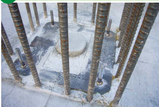
7 サップボルト溶接完了
