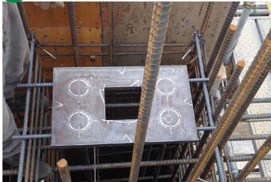
3 アンカープレート据え付け
