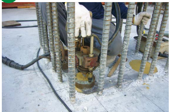
6 サップボルト溶接作業
