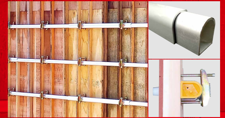
型枠一本締め工法
