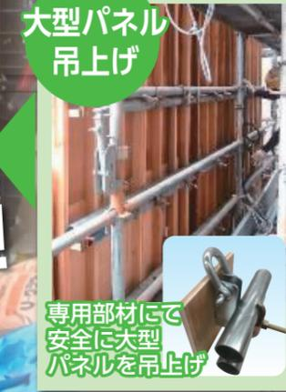
専用部材にて安全に大型パネルを吊上げ
