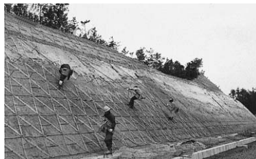
2 トライフレームの設置
