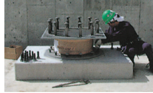
【写真17 ボルト仮締め】
