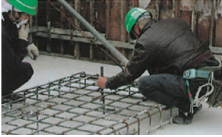
【写真5 アンカー打設】
