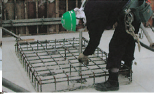
【写真4 アンカー孔掃除】
