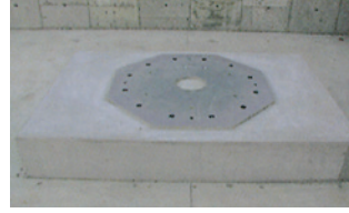
【写真13 コンクリート打設】
