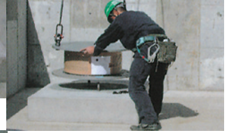
【写真14 積層ゴム据付け状況】
