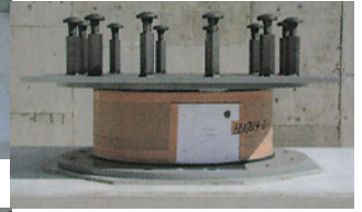
【写真16 上部オクトベース設置】
