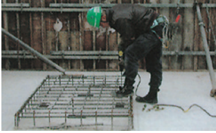
【写真3 アンカー孔挿孔】
