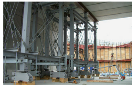
ラーク60システム（型枠支保工）
