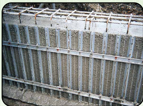
⑨コンクリート打設完了
