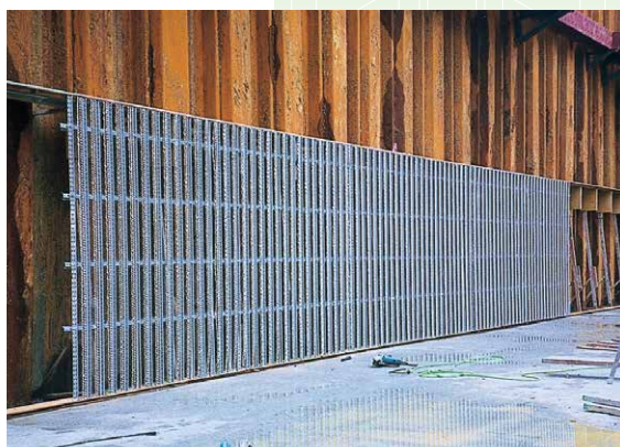
連続壁用裏込め型枠
