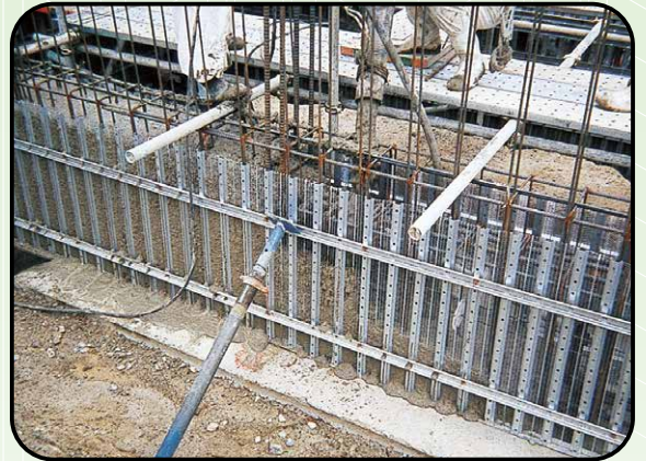
⑧ コンクリート打設
