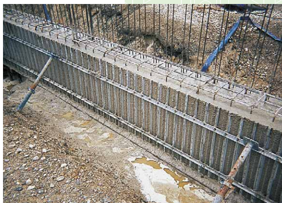
コンクリート打設完了
