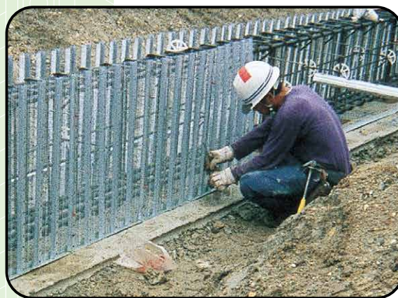
⑤返し側パンチングフォーム仮止め
