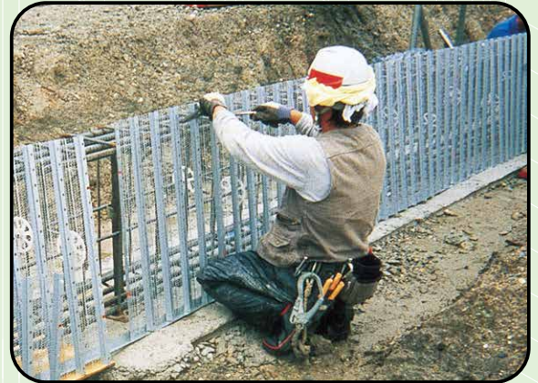
② パンチングフォーム準備(パネル連結、曲げ加工等) ③ パンチングフォーム配置
