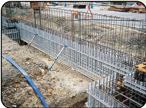
⑥ PFバタ取付・PFナット締付 ⑦ 通り出し・建入れ調整
