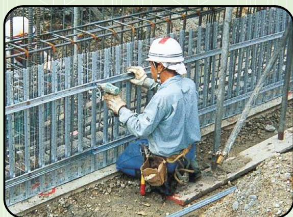
④PFバタ取付・PFナット締付
