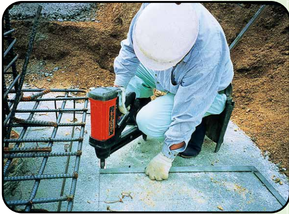
① PF下ランナー コンクリート釘止め
