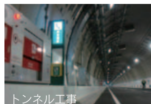
トンネル工事
