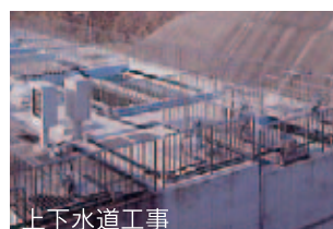
上下水道工事
