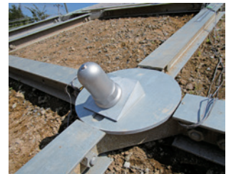
地山補強材施工例
