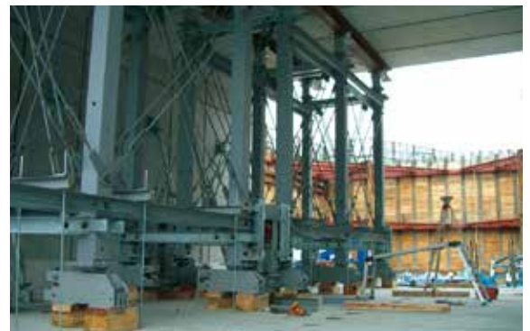
ラク60システム (支保工)
