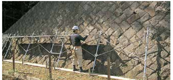
②鋼製布板設置
