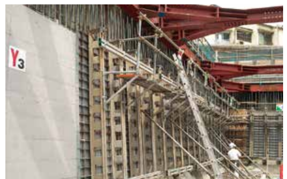
免震構造地下擁壁
