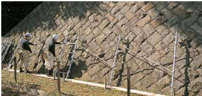
①のり支柱設置
