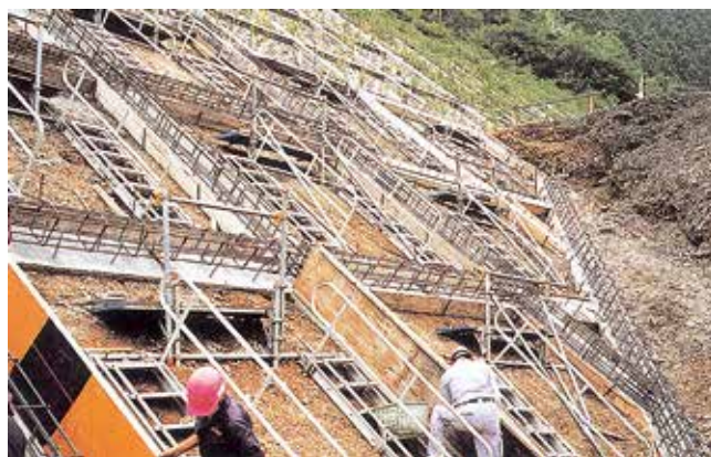
法面現場設置
