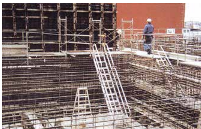
ケーソン階段設置
