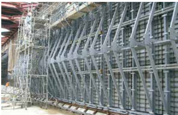
ボックスカルバート側壁
