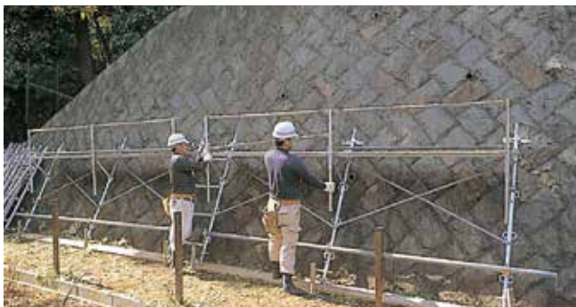
③のりスライド手摺設置
