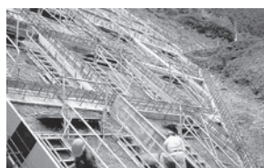
法面現場設置
