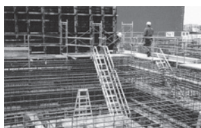
ケーソン階段設置
