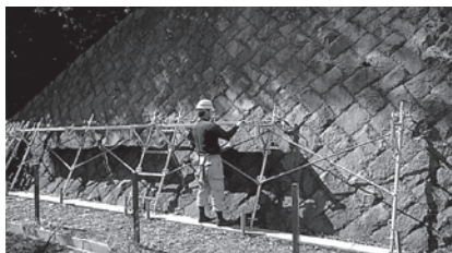
②鋼製布板設置
