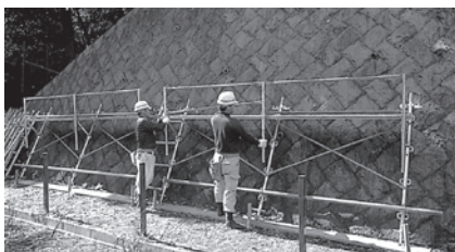
③伸縮手すり設置
