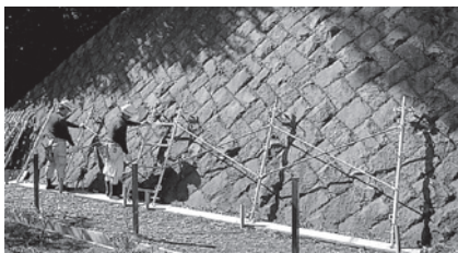
①のり支柱設置
