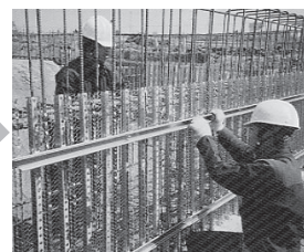
④PFバタ取付・PEナット締付
