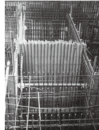
地中梁にセット完了時
