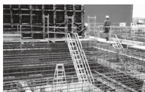
ケーソン階段設置
