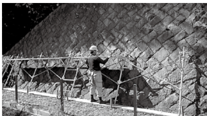
②鋼製布板設置
