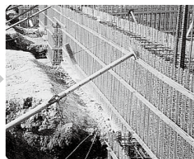
⑥PFバタ取付・PEナット締付 ⑦通り出し・建入れ調整
