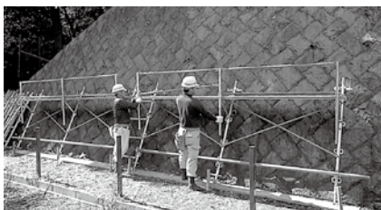
③伸縮手すり設置
