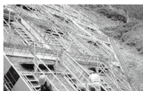
法面現場設置
