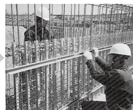
④PFバタ取付・PEナット締付
