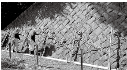
①のり支柱設置
