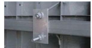
※吊り金具Sは柱型枠の重量に応じて取付個数が決まります。
