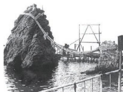
▲伊勢二見ヶ浦の夫婦岩:風雨や波浪による浸蝕、破損が激しいのでエスダインジョイナーWを使って保全工事
