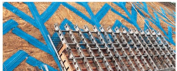
のり面排水および構造物裏面排水
