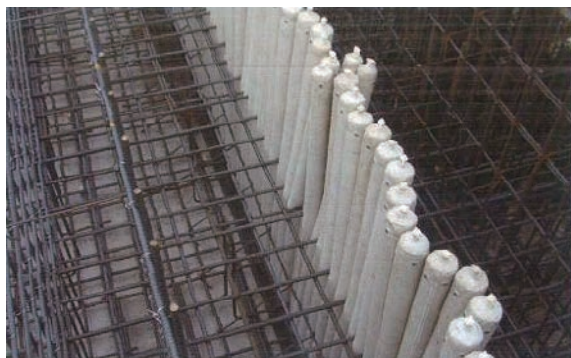
耐圧盤(TF-W)縦使い施工
