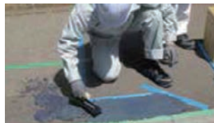
土間コテにて敷均し
