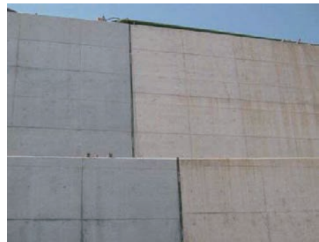
地下構造物の目地に使用
