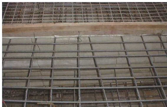
耐圧盤(TF)横使い施工
