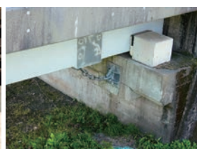
橋台の桁受け部
