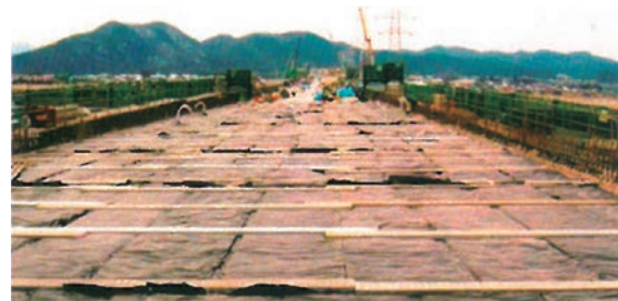
Qマット使用例(高架橋スラブ)
