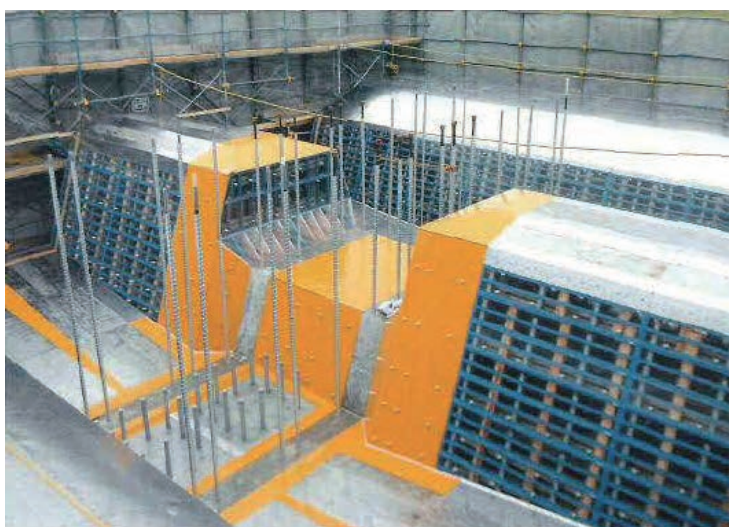
上部工全面施工
