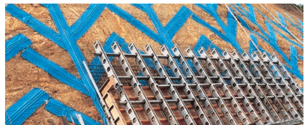
のり面排水および構造物裏面排水
