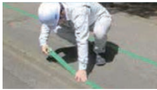
清掃後、乾いた面に養生
