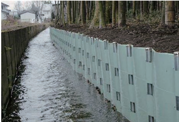
河川・簡易水路・仮設水路
