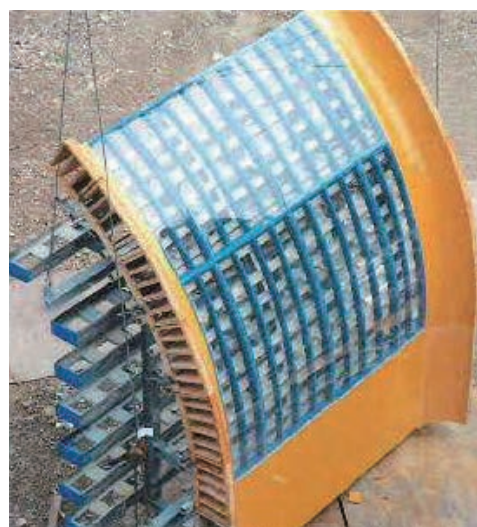
橋脚下部工(梁底アール部)
